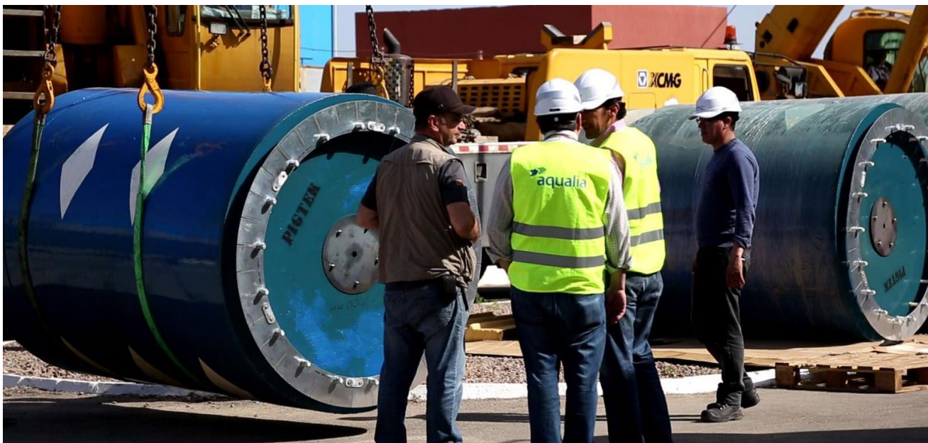
Tecnología PIG aplicada en la limpieza de los conductos de captación de agua de la desaladora de Mostaganem, Argelia.
