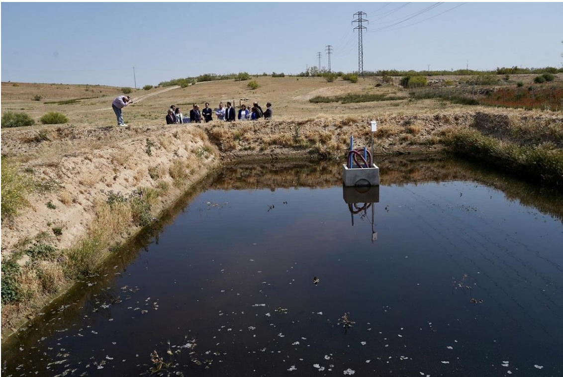
Visita a la balsa de infiltración, durante el acto de presentación al alcalde de la localidad y a los medios del proyecto MARadentro en la depuradora de Medina del Campo, Valladolid.
