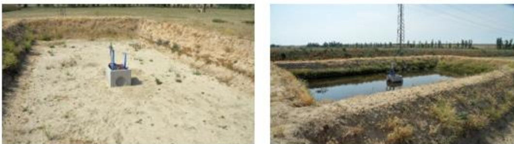
Imagen 4: "Isla" antes y después del llenado de la balsa de infiltración.
