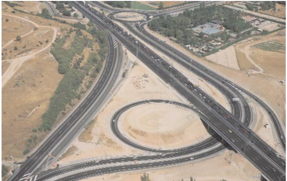
■ Conexión de la M-50 con la variante de la A-1. Enlace con Algete. Madrid
