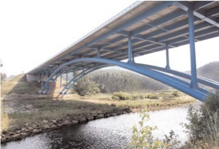
■ Viaducto sobre el río Escudo. Autovía del Cantábrico
