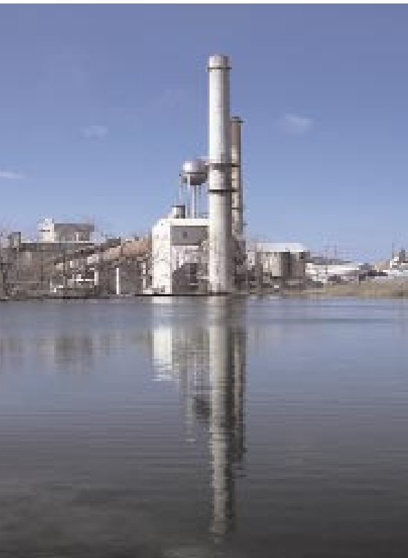
■ Fábrica de cemento en Keystone. EE.UU.
