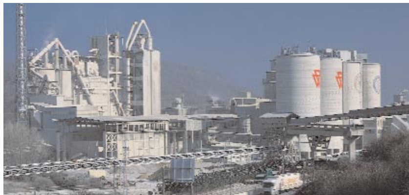
■ Fábrica de cemento. Olazagutía. Navarra
