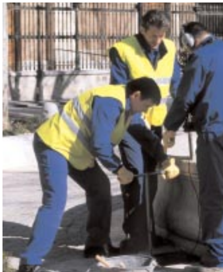
■ Distribución de agua potable y alcantarillado en Alcalá de Henares. Madrid
