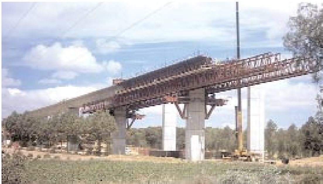
■ Autovía del Duero A-11. Tramo Toro-Zamora. Viaducto sobre el arroyo Adalia
