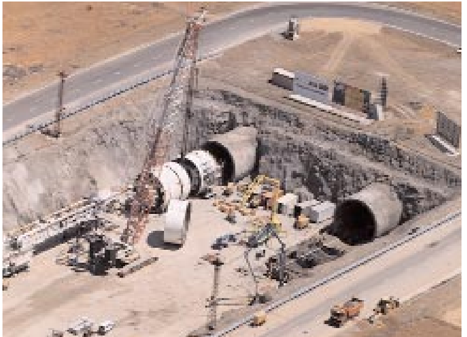
■ Túneles de Guadarrama. Madrid
