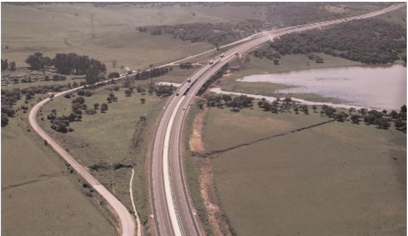
Autovía A-381, Jerez-Los Barrios
