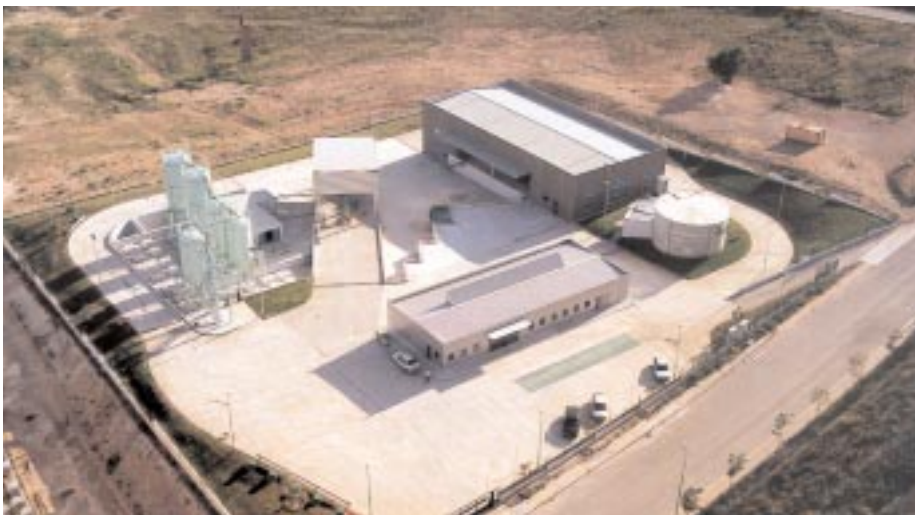
■ Planta de tratamiento de residuos industriales en Valdebebas. Madrid
