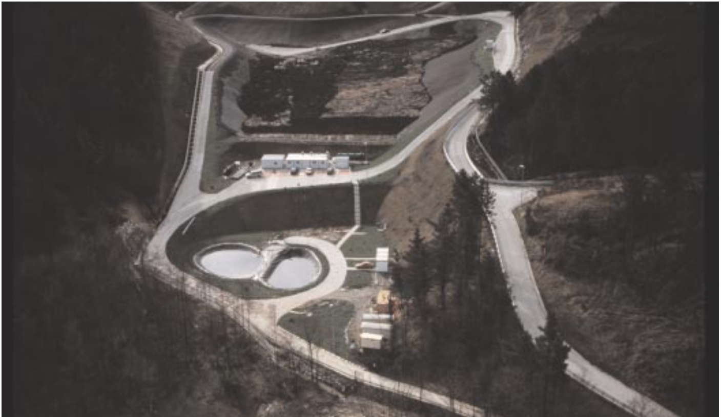
■ Vertedero de residuos industriales. Bisbieta. Bilbao
