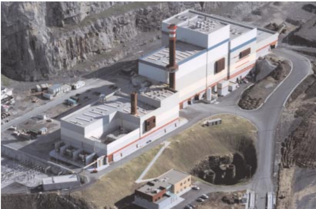
■ Planta de valorización energética de Residuos Urbanos (RSU) de Zabalgardi. Vizcaya
