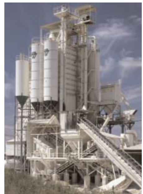
■ Planta de mortero seco. Álcala de Guadaira. Sevilla
