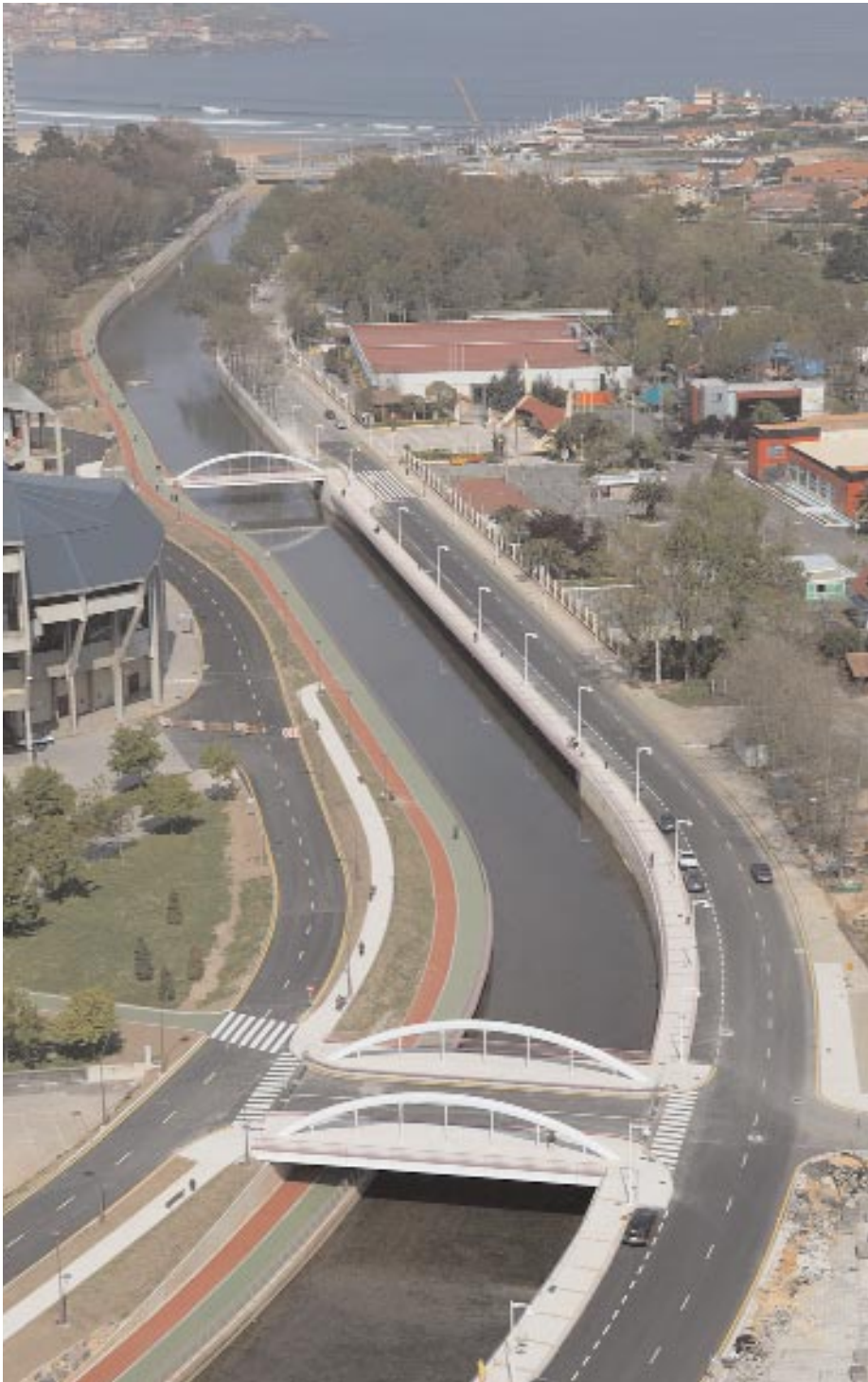
■ Acondicionamiento del río Piles. Gijón
