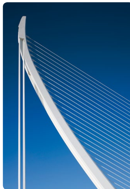
PUENTE DEL AZUD DEL ORO, VALENCIA.
