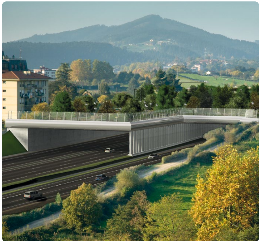
PASARELA DE AMOREBIETA, VIZCAYA.
