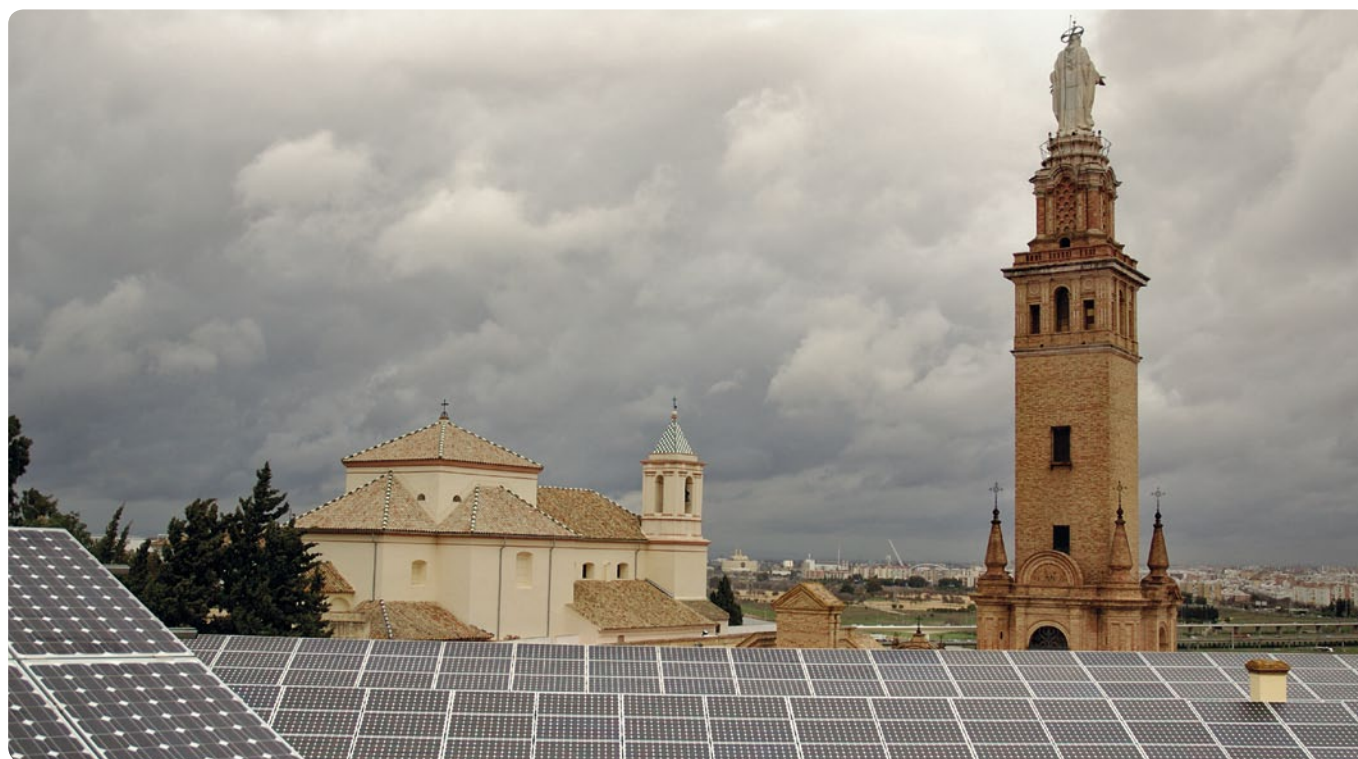
PANELES FOTOVOLTAICOS, SAN JUAN DE AZNALFARACHE. SEVILLA
