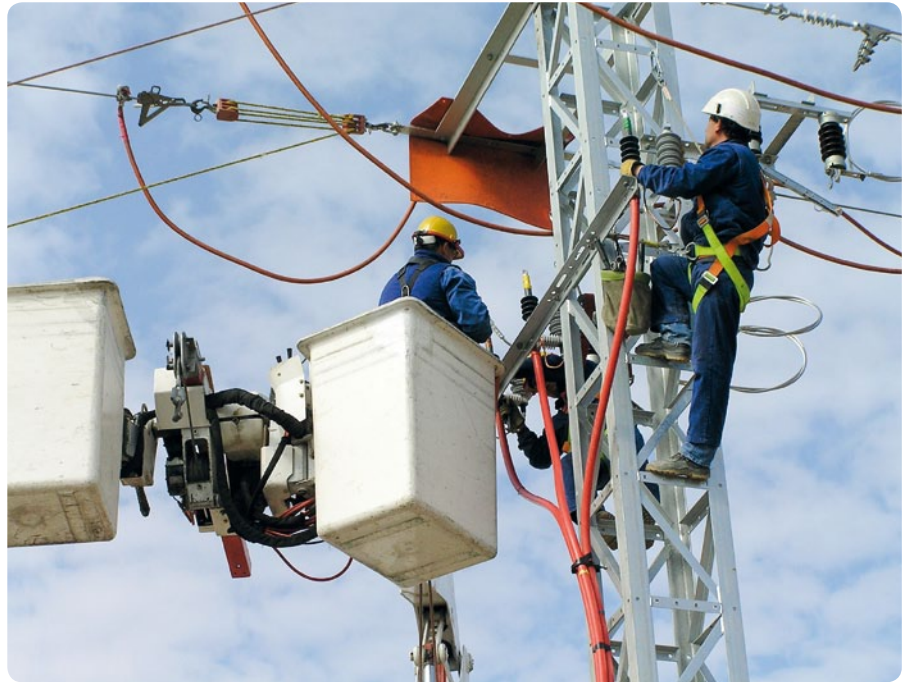
TRABAJOS EN ALTA TENSIÓN
