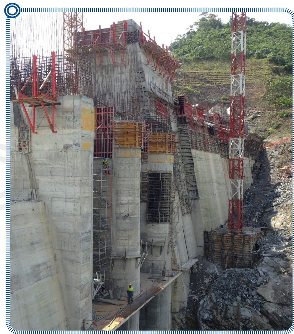
Presa de Bajo Frío (Panamá)
