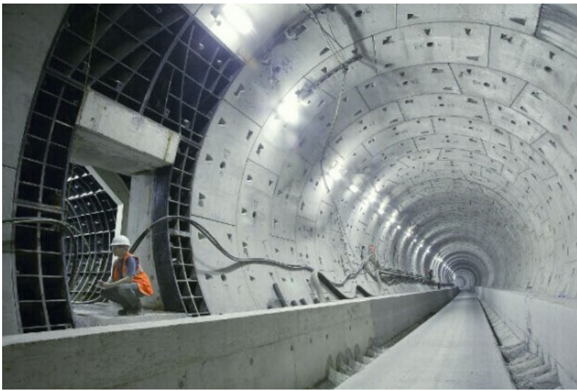
Túnel del London Crossrail (Foto cedida por LCR)
