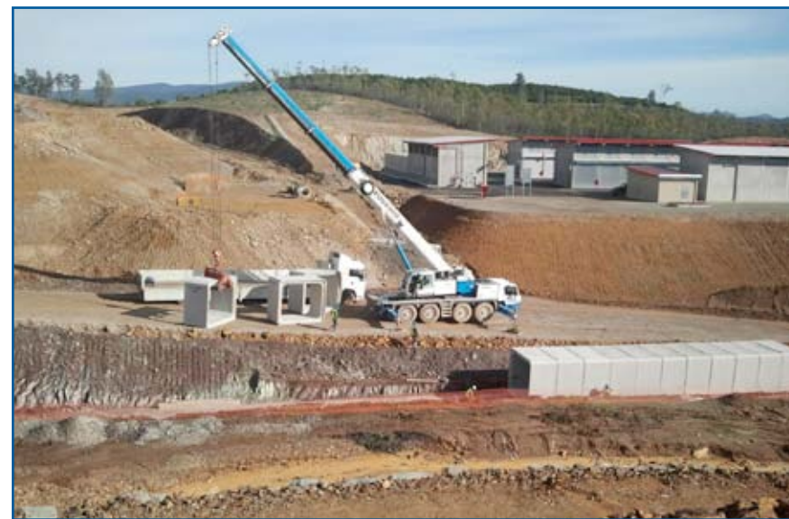
Colocación de estructuras modulares de hormigón armado.
