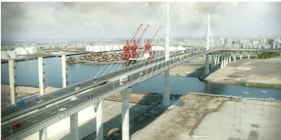
Puente Gerald Desmond, Los Ángeles (EE.UU.).
