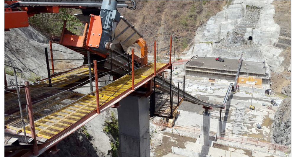
Presa de Chucás (Costa Rica).
