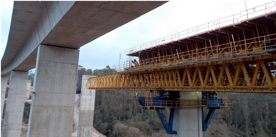
Viaducto sobre el río Cabra. Autovía del Cantábrico (España).
