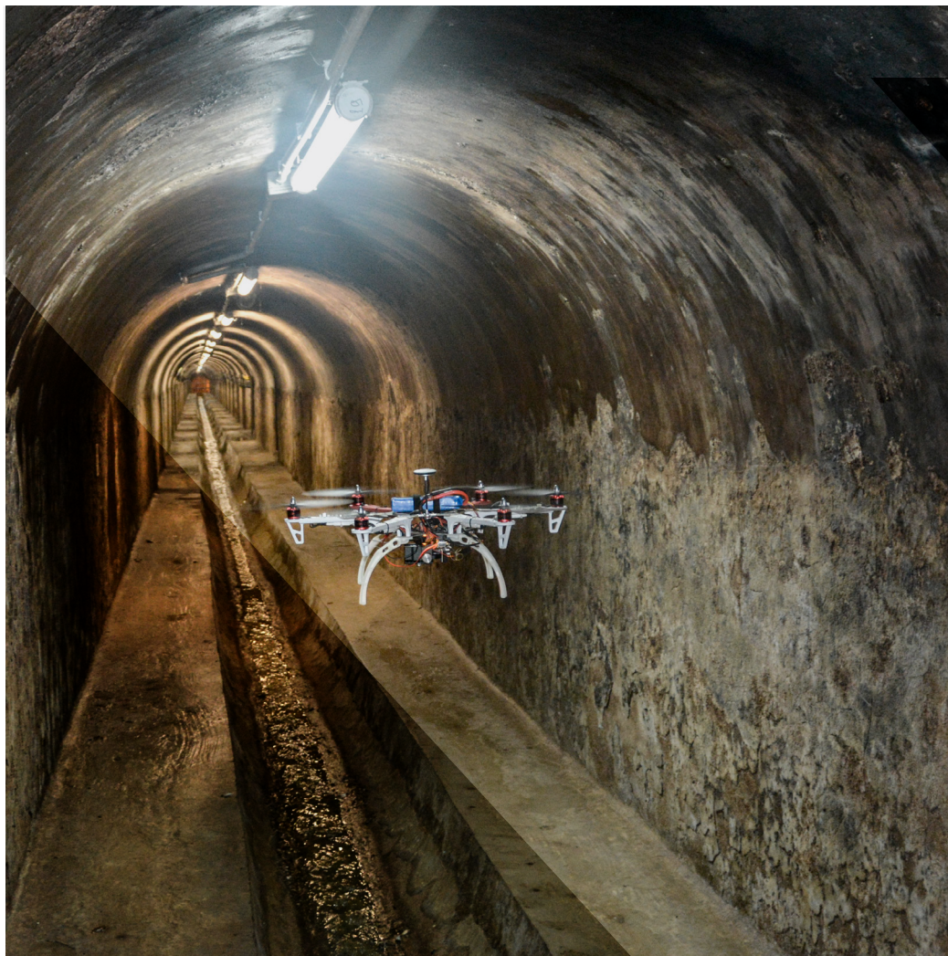
Un dron inspecciona el alcantarillado de Barcelona (España).
