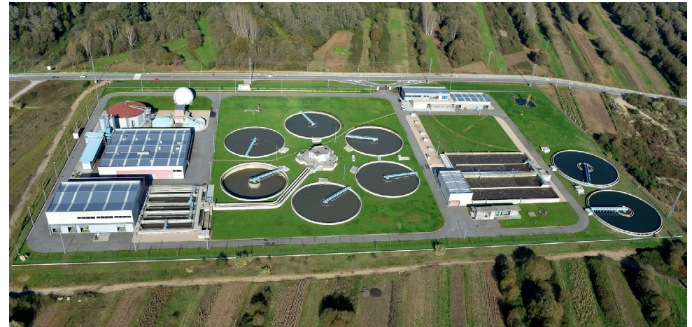
Estación Depuradora de Aguas Residuales de Guillarei, Tui (España).
