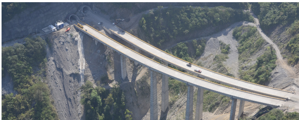
Viaducto de San Marcos. Autopista Nuevo Necaxa-Ávila Camacho (México).
