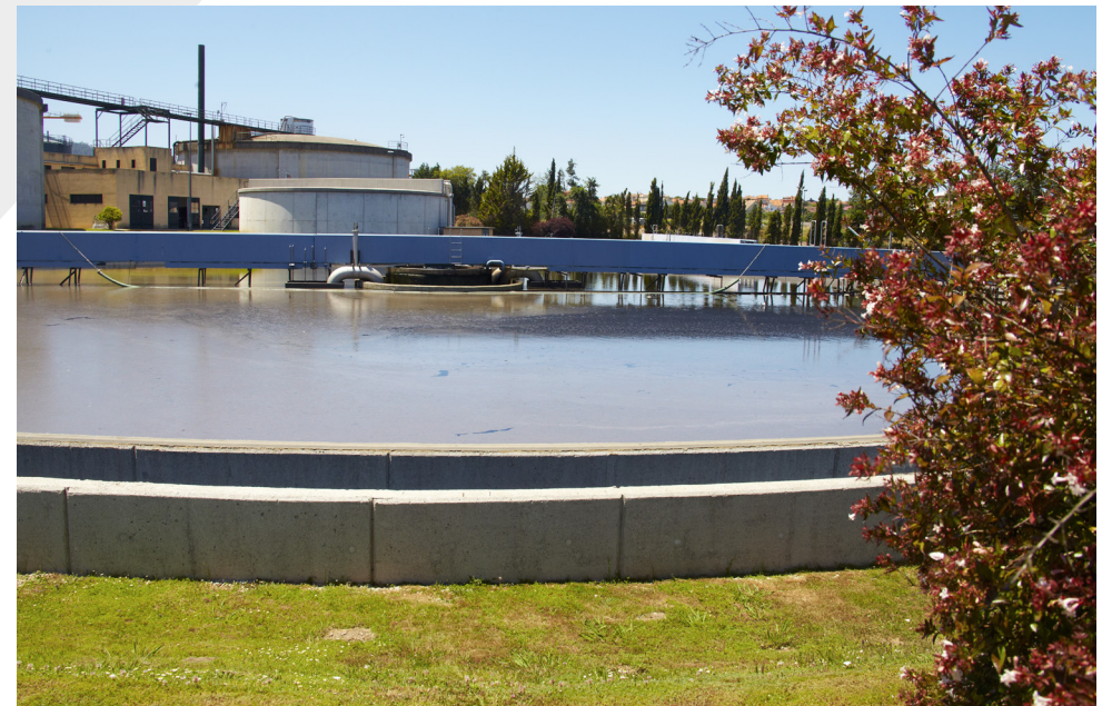
Estación Depuradora de Aguas Residuales de Vigo (España).
