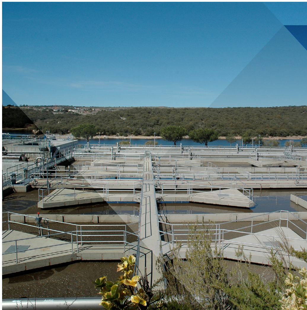
Estación Depuradora de Aguas Residuales de Ávila (España).
