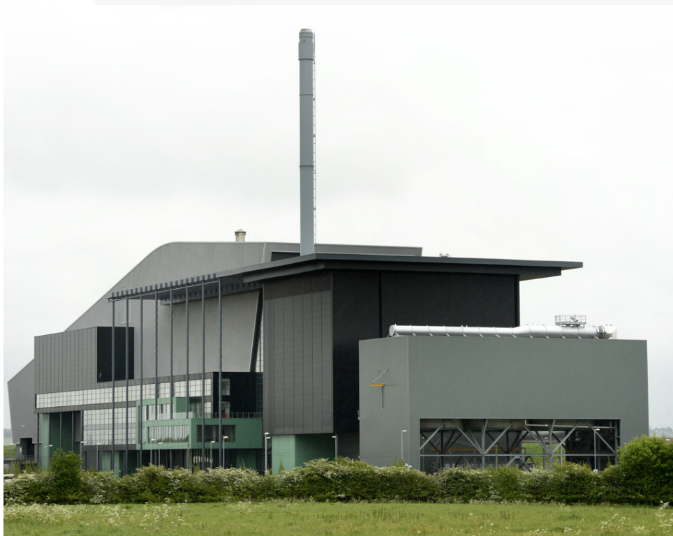
Planta incineradora de Lincolnshire (Reino Unido).
