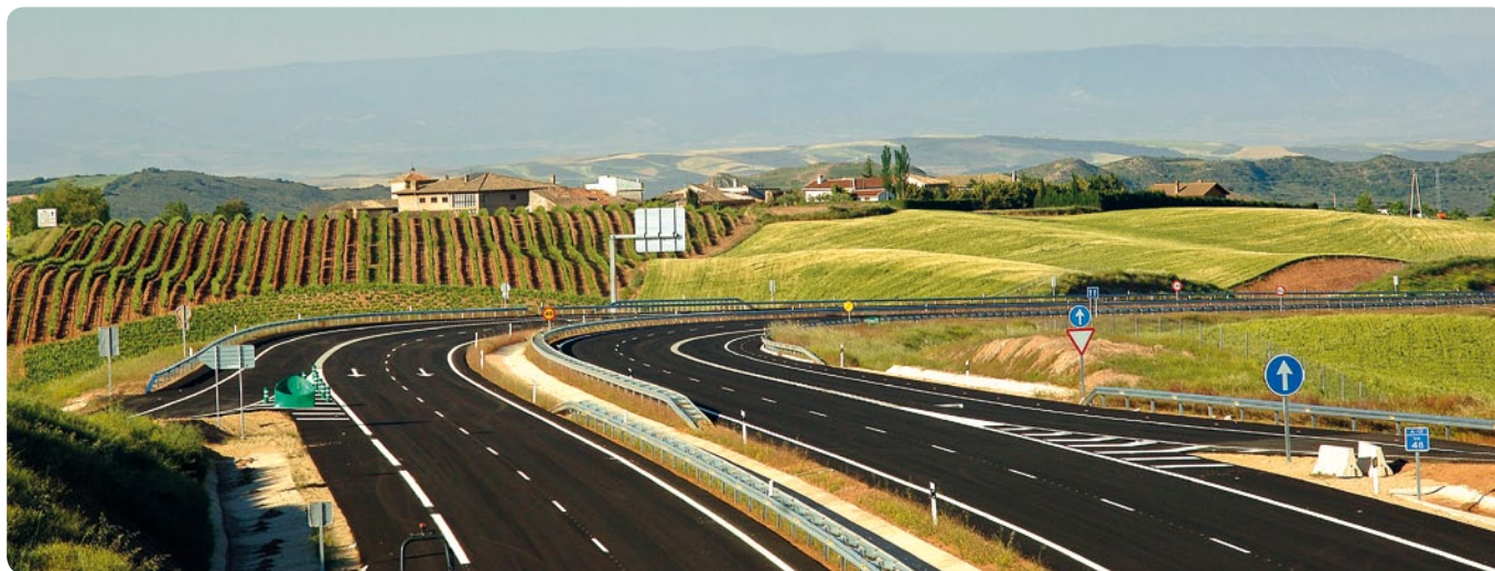
AUTOVÍA DEL CAMINO, NAVARRA.
