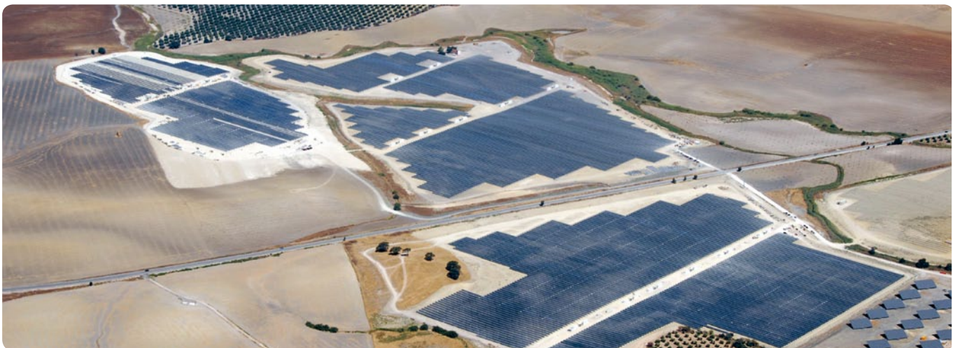
PARQUE SOLAR FOTOVOLTAICO, ESPEJO. CÓRDOBA
