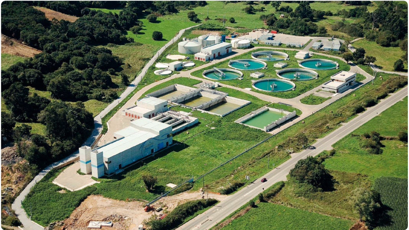
ESTACIÓN DEPURADORA DE AGUAS RESIDUALES, SAN PANTALEÓN. SANTANDER
