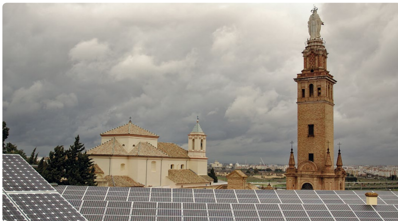
PANELES FOTOVOLTAICOS, SAN JUAN DE AZNALFARACHE. SEVILLA
