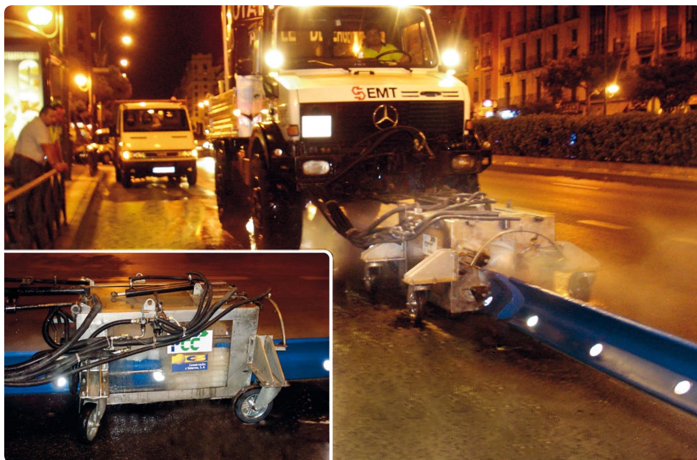
LIMPIEZA DE SEPARADORES CARRIL-BUS, MADRID.
