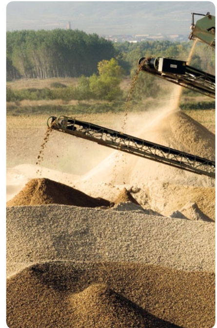
PLANTA DE GRAVA, PERALTA. NAVARRA
