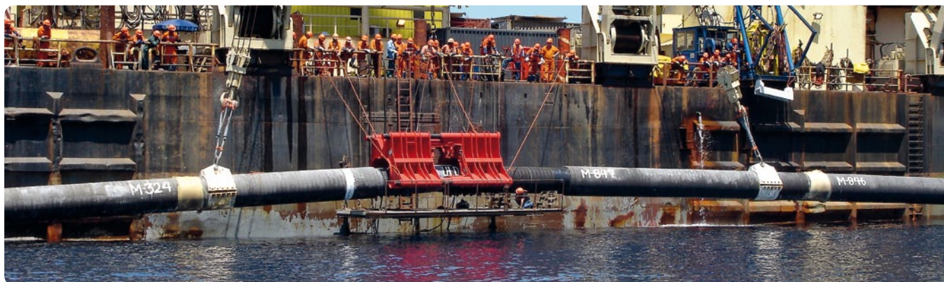
APROVECHAMIENTO DE LOS RECURSOS HIDRÁULICOS DE LA SIERRA DE TRAMONTANA, PALMA DE MALLORCA.
