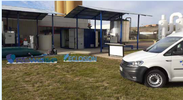
A la izquierda, fango desecado mediante sistema solar. A la derecha, Centro de Innovación en el Ciclo Integral del Agua en la EDAR de Salamanca.
