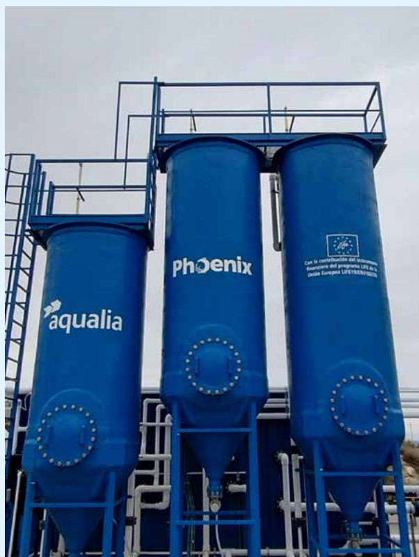
De izquierda a derecha, skid de filtros de lavado en continuo y semicontinuo; contenedor de desinfección con UV, O_3 y H_2O_2 .
