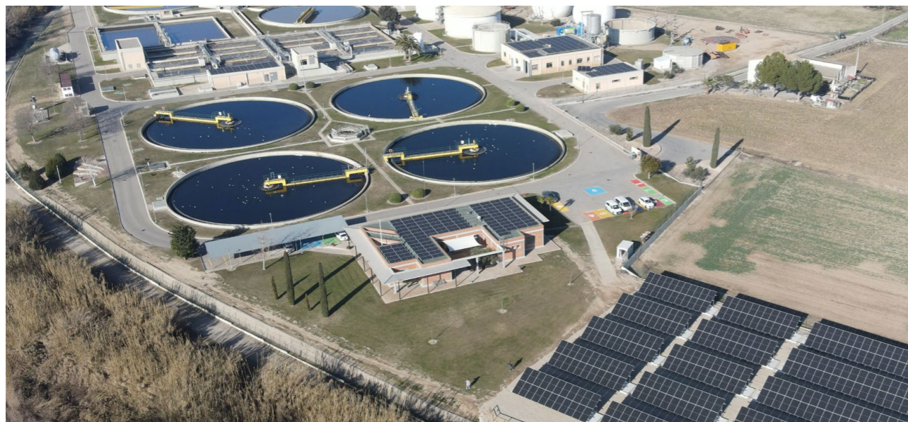
● Lleida WWTP, Spain.
