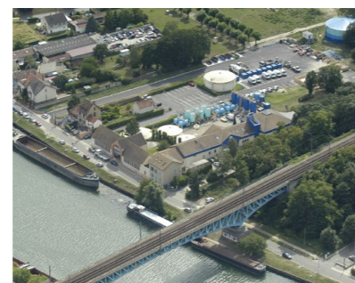
● Installations SEFO à Andrézy, France.
