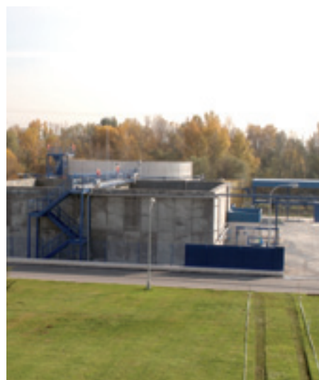
Planta depuradora de Wyeth.
