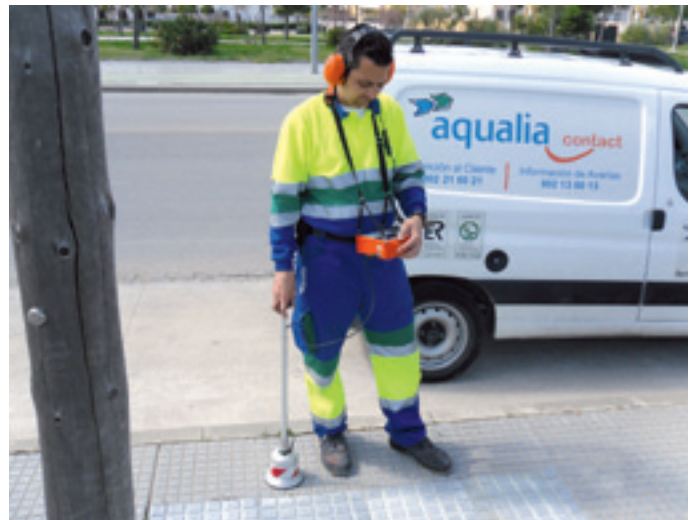
Personal de FCC Aqualia realizando tareas de búsqueda de fugas.
