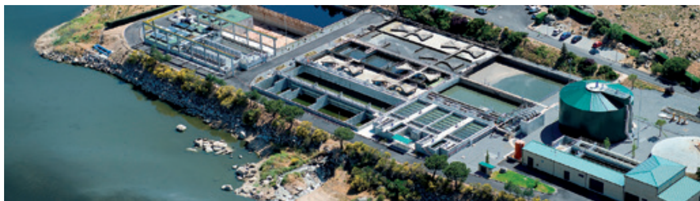
Vista aérea de la EDAR de Ávila.
