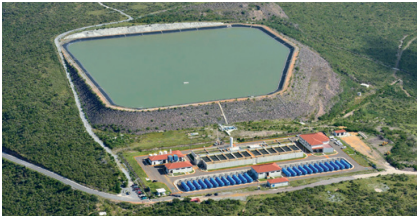
Acueducto y planta potabilizadora Acueducto II, México.
