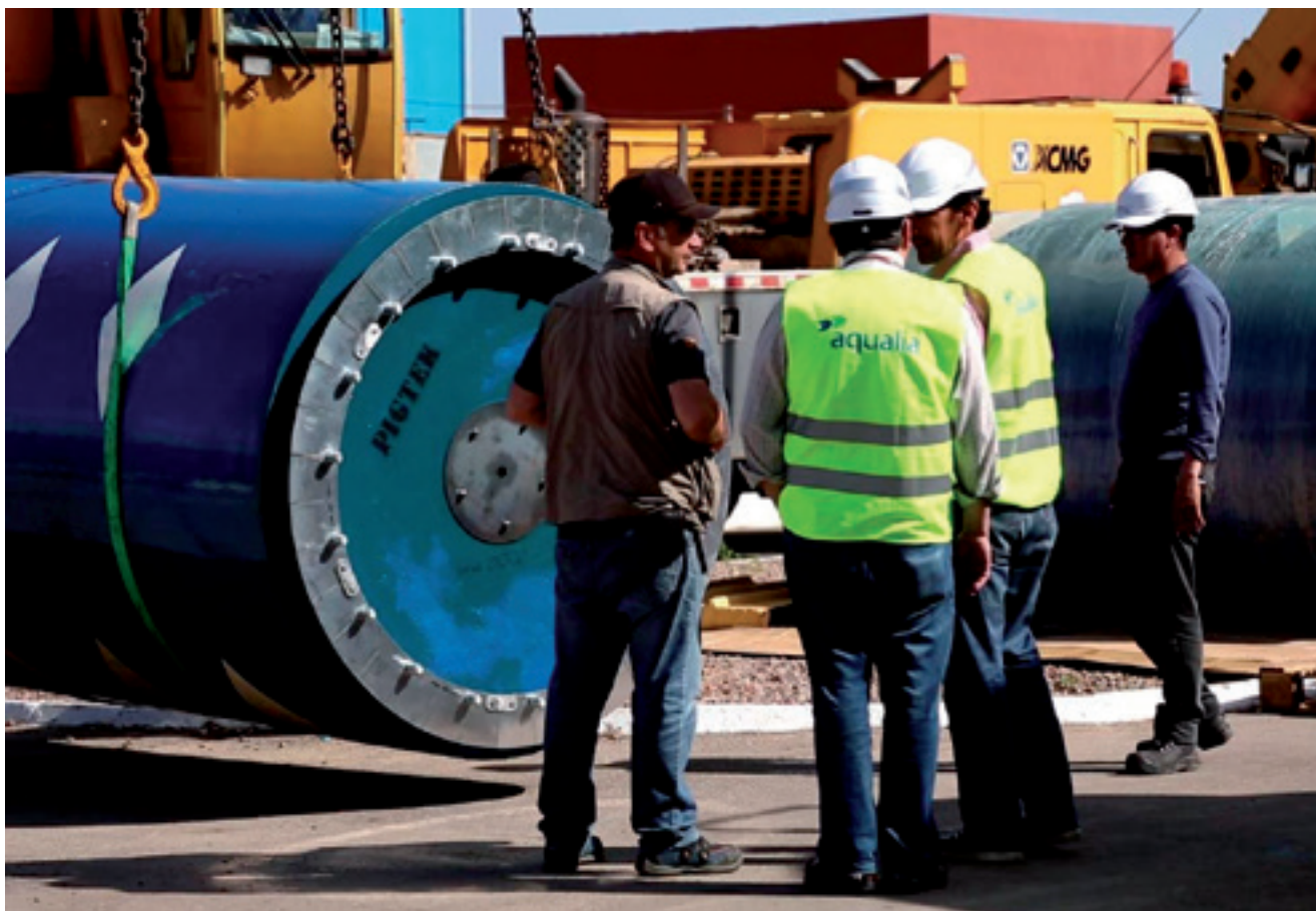
Tecnología PIG aplicada en la limpieza de los conductos de captación de agua de la desaladora de Mostaganem, Argelia.
