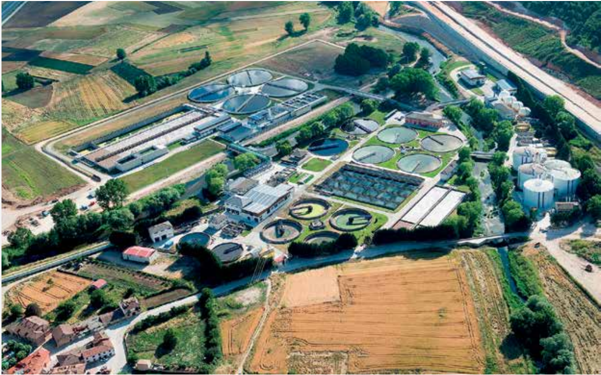
Vista aérea de la EDAR de Burgos.
