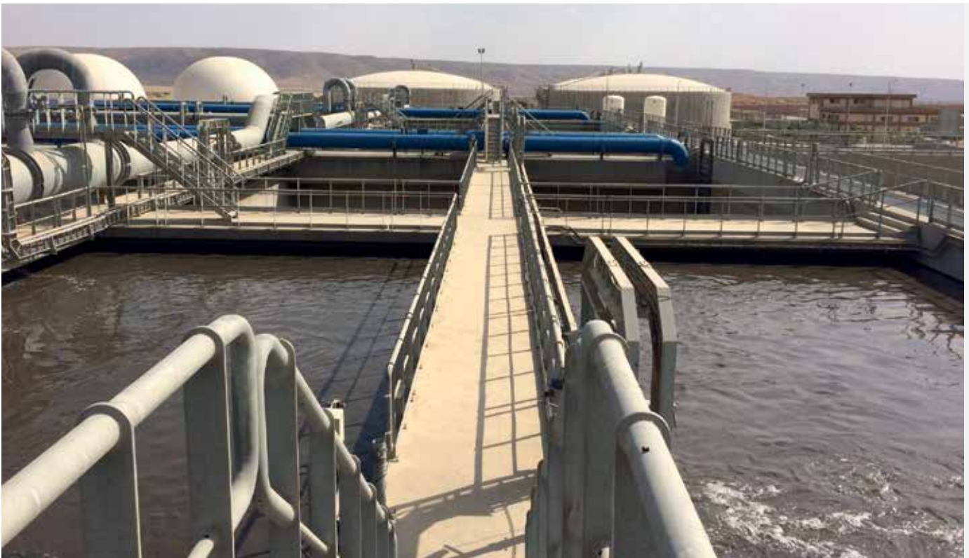
Depuradora de New Cairo.
