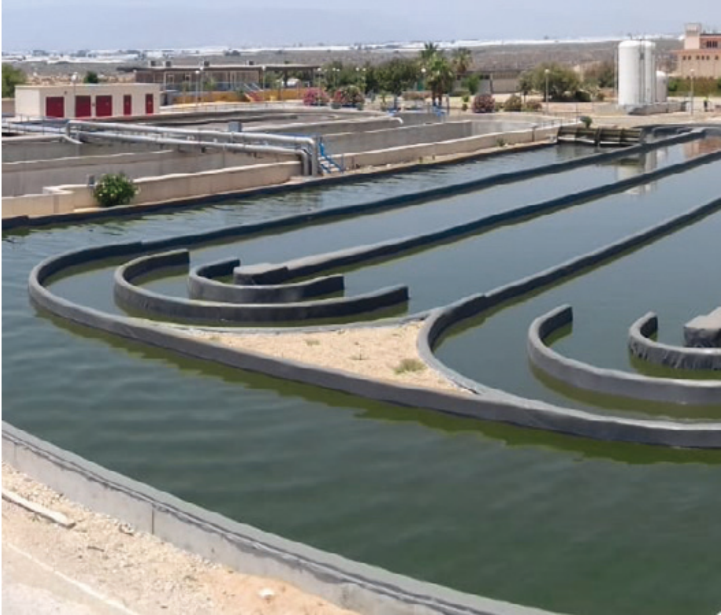
Incover Project in El Toyo WWTP (Almería).
