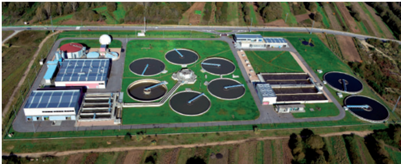
Vista aérea da ETAR de Guillarei onde se desenvolve o processo ELAN®, que reduz o gasto energético do tratamento.
