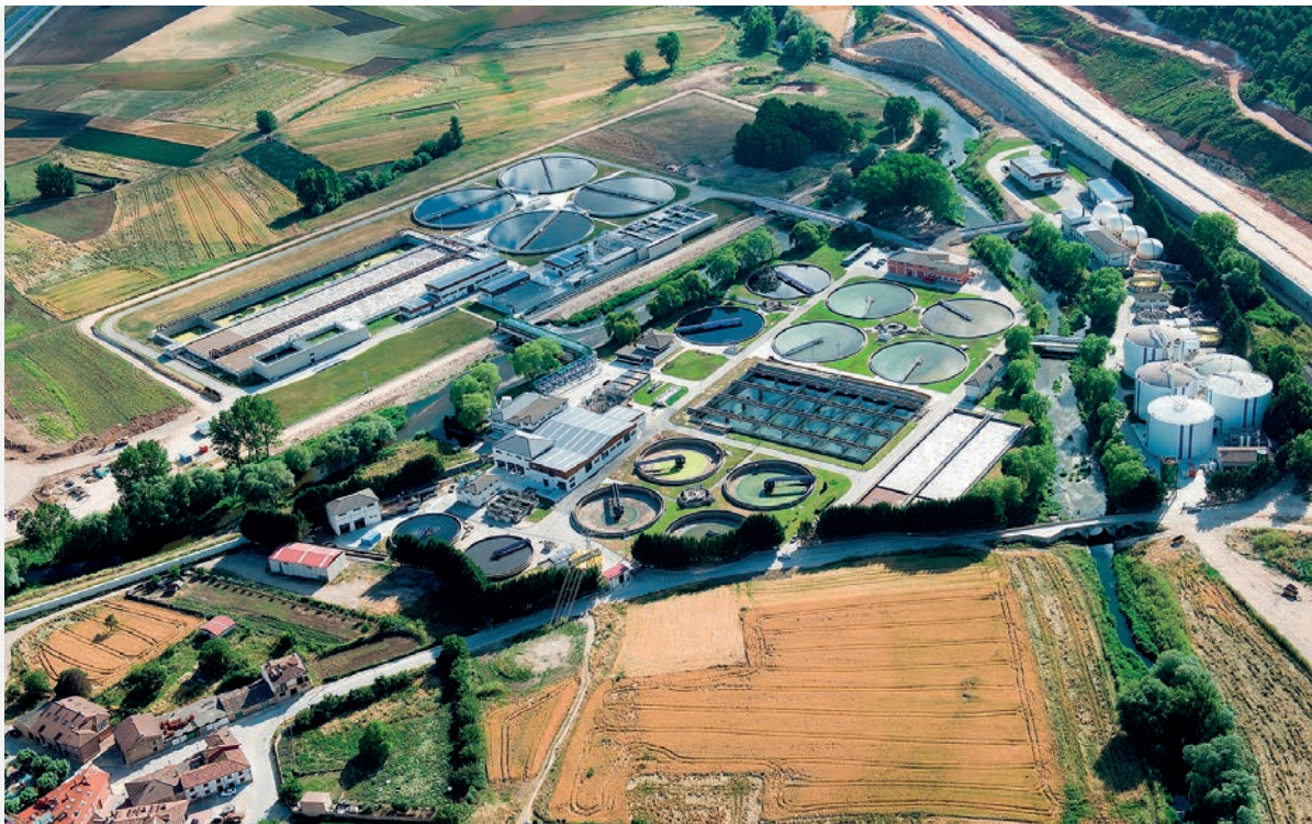
Vista aérea da ETAR de Burgos.
