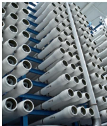
Bastidor de membranas da instalação Dessalinizadora de CapDjinet.
