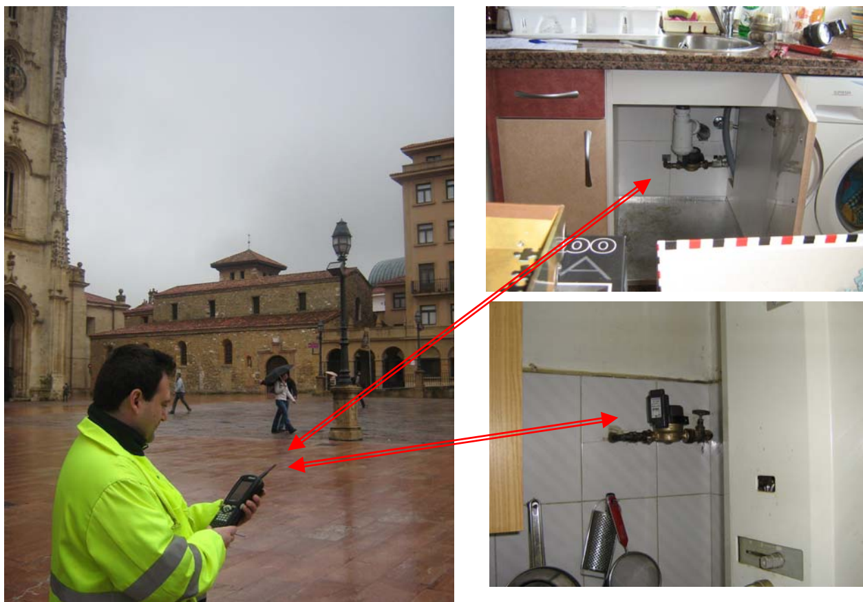
Lectura a distancia “vía radio” de contadores ubicados en interior de viviendas
