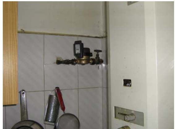
Lectura a distancia “vía radio” de contadores ubicados en interior de viviendas
