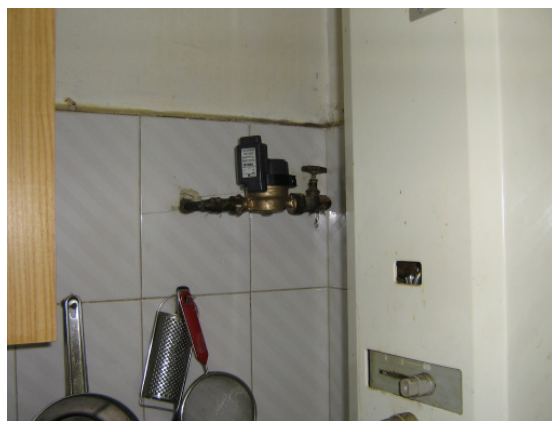
Lectura a distancia “ vía radio” de contadores ubicados en interior de viviendas
