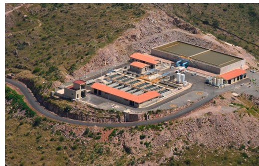
La station d'épuration d'El Realito (Mexique)
