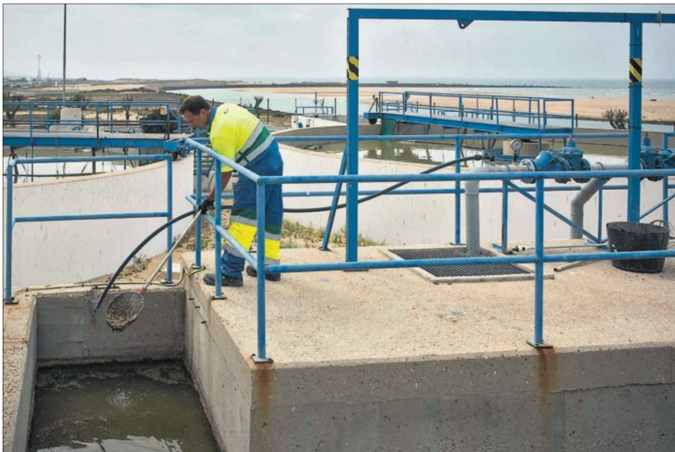
Un operario trabaja en la depuradora de Barbate (Cádiz), que no cumple los requisitos de tratamiento que exige la ley. / M. MORENO
