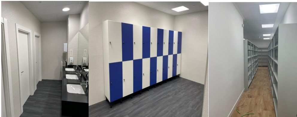
Foto detalle techo zona aseos, vestuarios y almacenes
