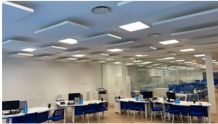
Foto detalle techo zona de atención al público con elementos fono absorbentes
