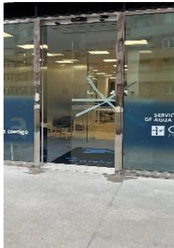
Foto detalle puerta acceso motorizadas
