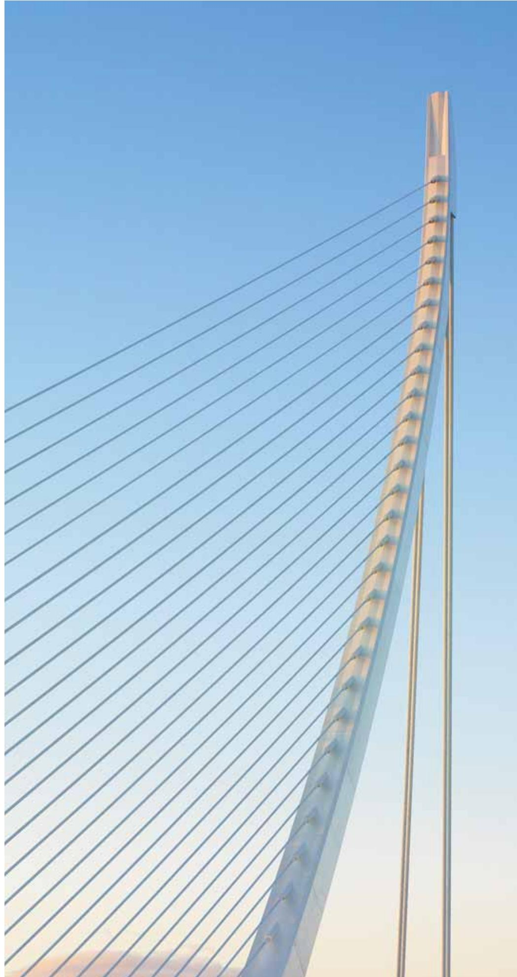
El puente tiene una longitud de 180 metros y un gran mástil inclinado de 123 metros de altura que aguanta un haz de 29 cables de acero dispuestos en arpa.
