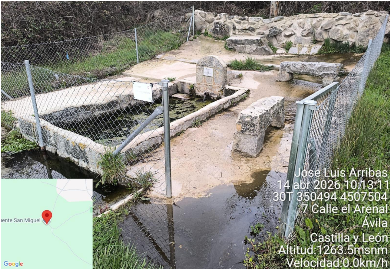
Fotografía 7 La Alamedilla Lavaderos
