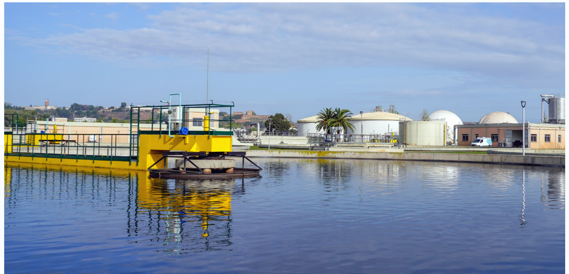
Estación Depuradora de Aguas Residuales (EDAR) de Lleida (España).
