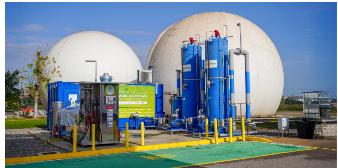
Estación Depuradora de Aguas Residuales (EDAR) de Lleida (España).
