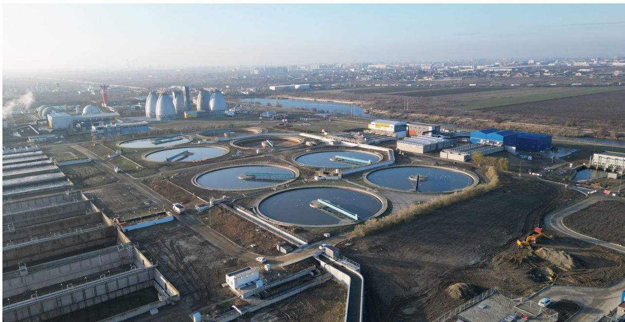
Vista general de la EDAR Glina, Rumanía.
