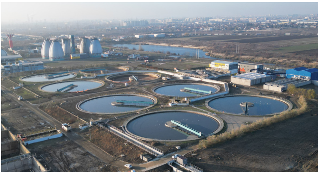
Vista aérea de la planta de Glina, la depuradora de mayor capacidad de Rumanía.
