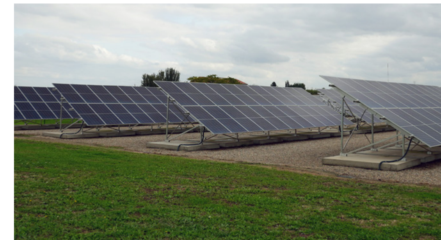
Estación Depuradora de Aguas Residuales (EDAR) de Lleida (España).
